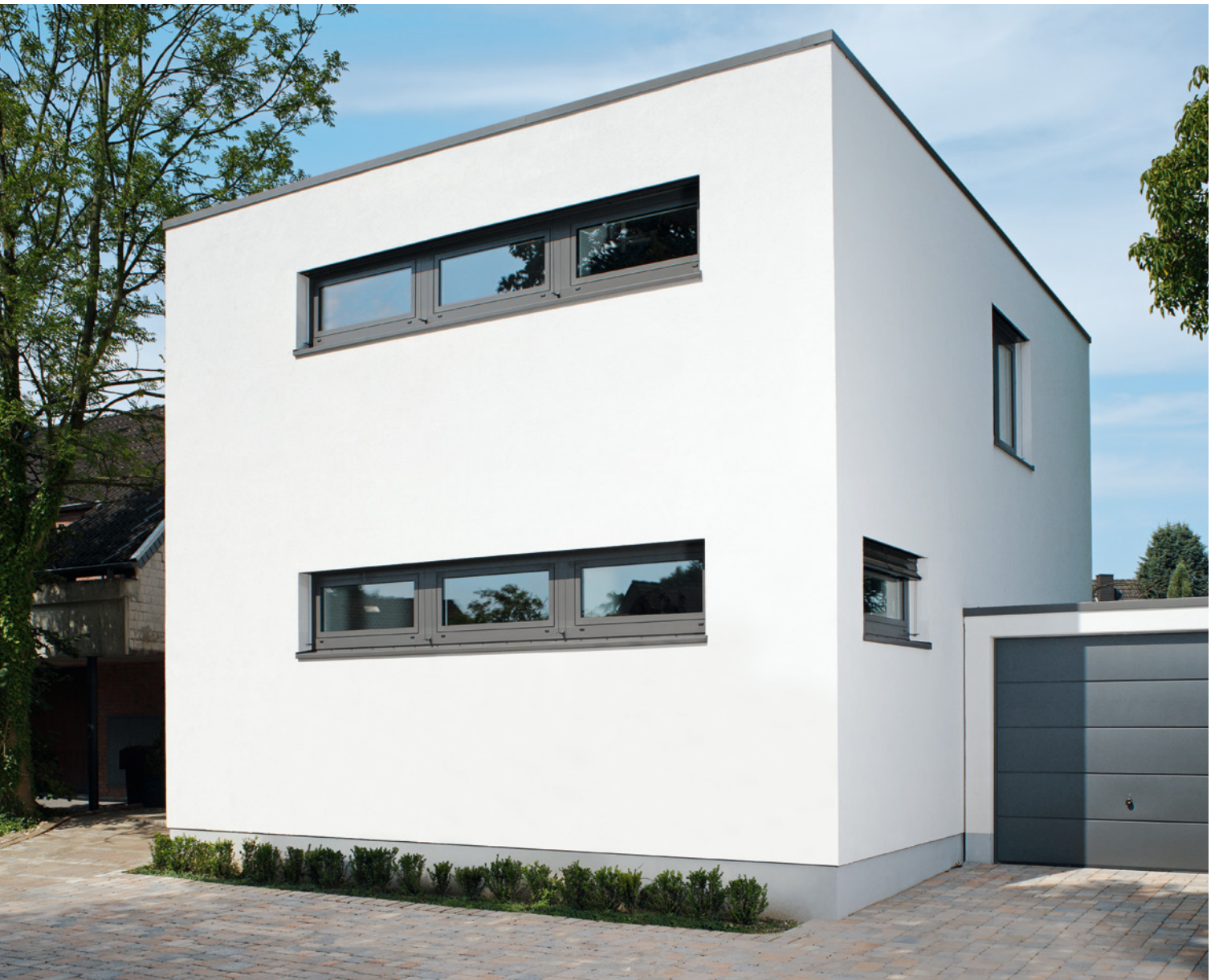
Fenster sind dominante Gestaltungselemente.
